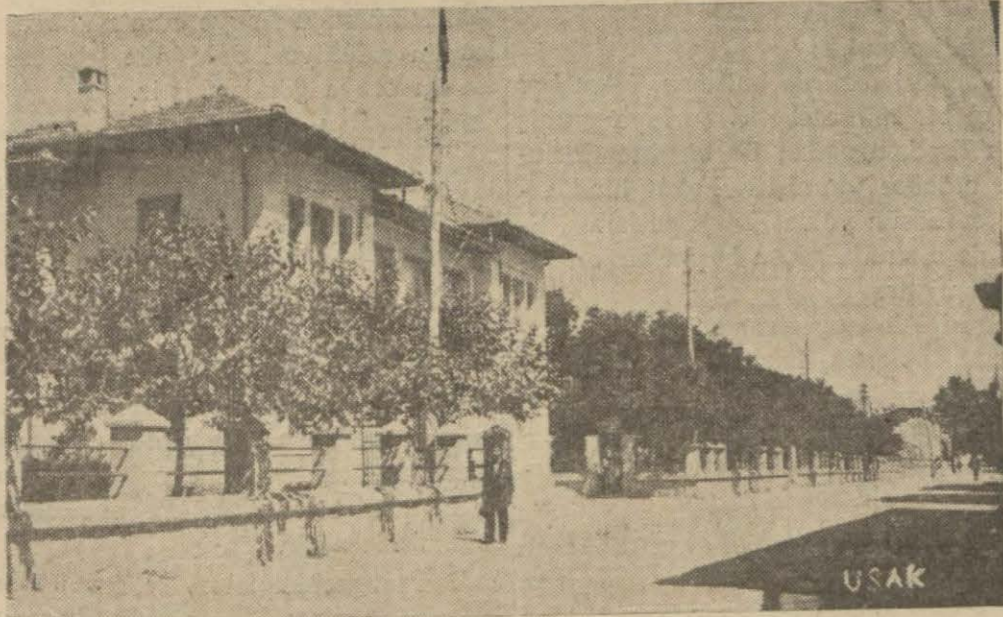
Uşak İstasyon caddesi ve Halkevinden bir görünüşü.
